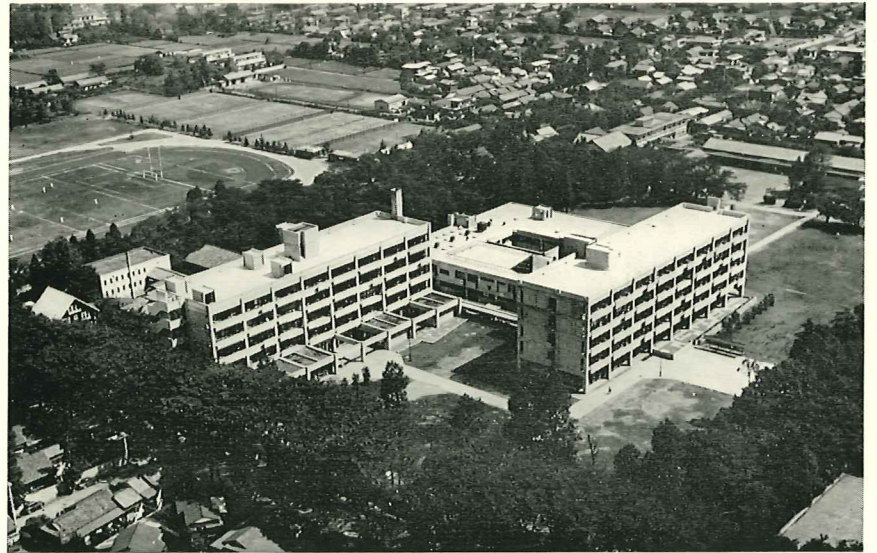
新たに4・5階を増築した工学部全景
